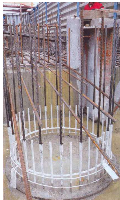
Továbbszerelésre előkészített medercölöp
